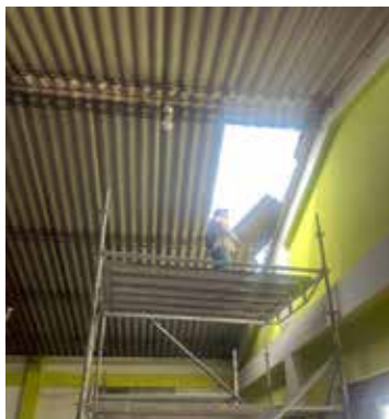
Retiro de planchas
